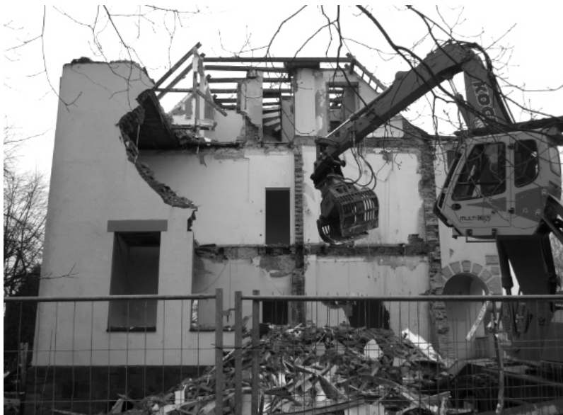
Das alte Pfarrhaus wird abgerissen, 2012
